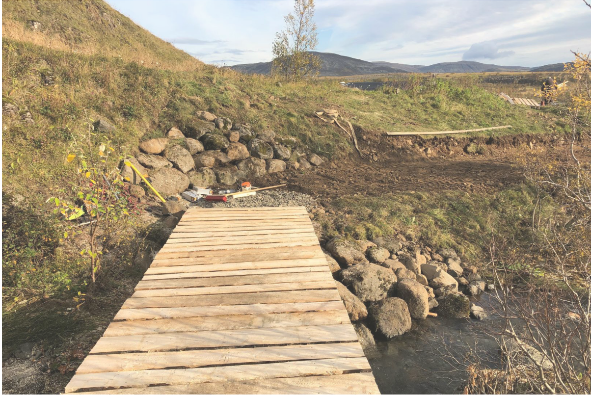
Byggðar voru tvær göngubrýr úr efnivið úr Heiðmörk og þeim komið fyrir á svæðinu.
